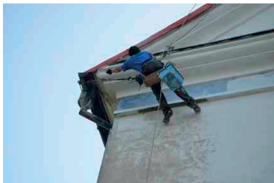
Práce na opravě fasády kostela
