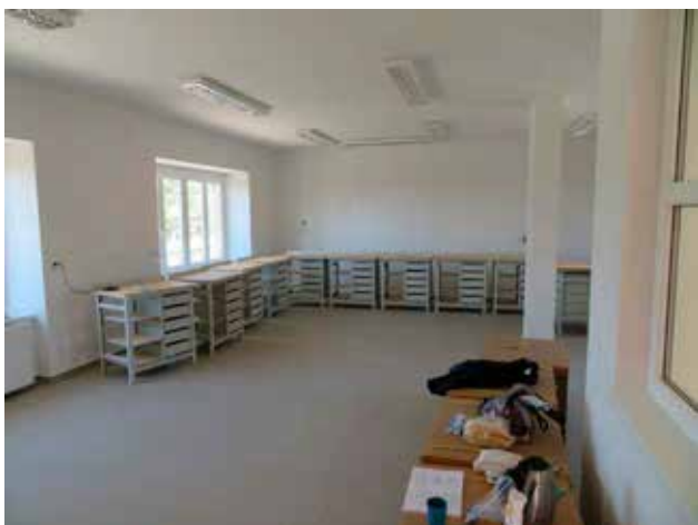
Školní dílny před a po rekonstrukci
