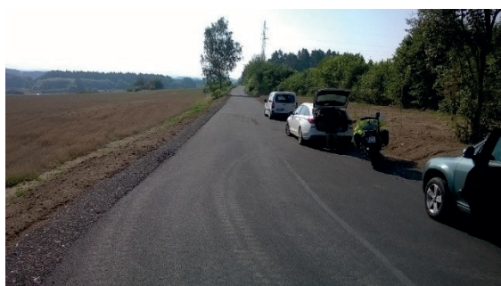
Opravená obecní cesta Velešice-Třebomyslice
