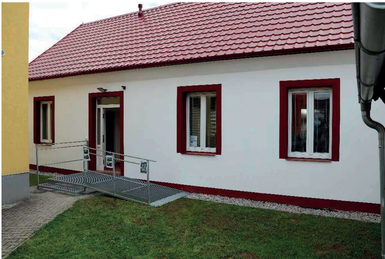
1/ Pohled na nově rekonstruované školní dílny – vstup
