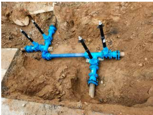
Opravený šoupatový uzel
