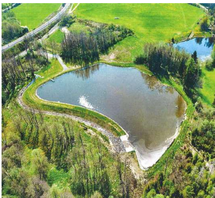
2020 Vybudovali jsme vodní nádrž na Prachárně
