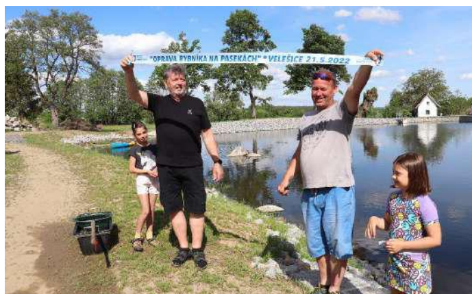
2022 opravili jsme rybník ve Velešicích
